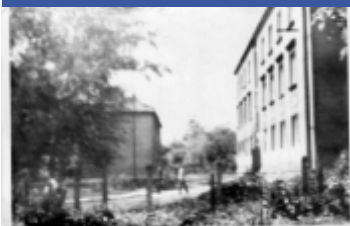
Budynek hotelu robotniczego. Został przebudowany i obecnie w nim znajduje się "ZAKŁAD OPIEKUŃCZO-LECZNICZY DLA PRZEWLEKLE CHORYCH".
