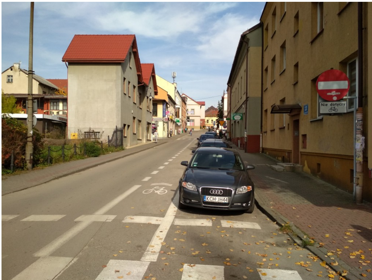
Ilustracja 2: Kontrapas rowerowy wyznaczony w ciągu ul. Świętokrzyskiej w Chrzanowie. UWAGA: Pas ruchu dla rowerów powinien zostać oznakowany znakiem poziomym typu P-23.
