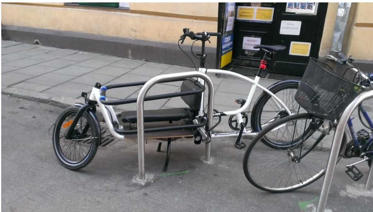
Ilustracja 5: Stojak umieszczony w jezdni w odpowiedniej odległości od chodnika pozwala zaparkować nawet nietypowy rower.
