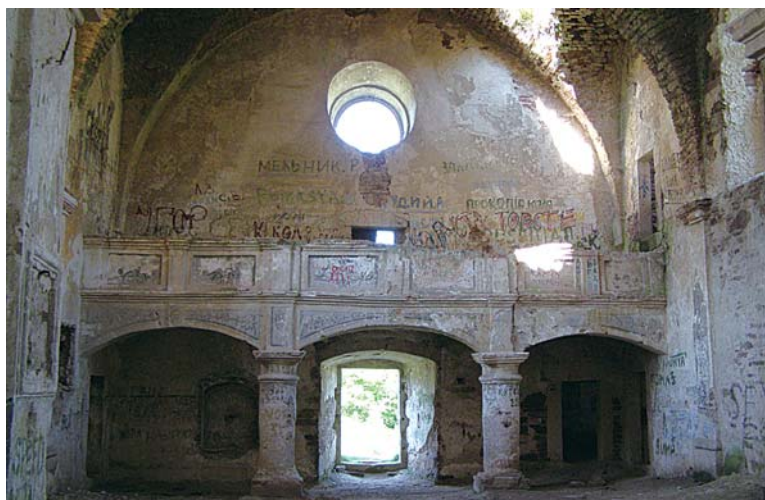
Wnętrze zniszczonego kościoła
