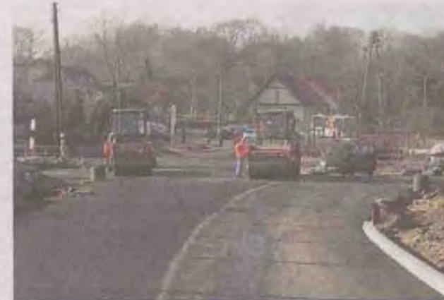
Rozbudowa odcinka DW 781 – ulica Szpitalna
