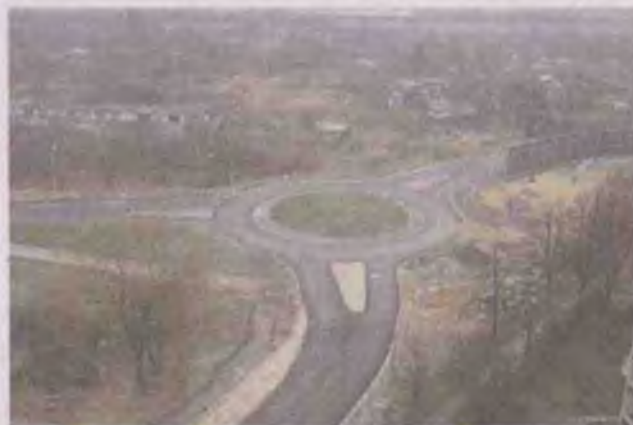
Budowa odcinka od ulicy Zielonej do ulicy Balińskiej
