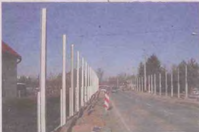
Rozbudowa odcinka DW 781 – ulica Szpitalna
