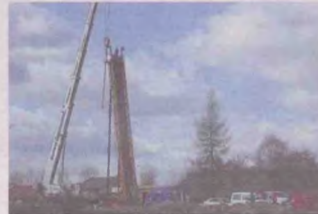
Rozbudowa odcinka DK 79 - ulica Trzebińska
