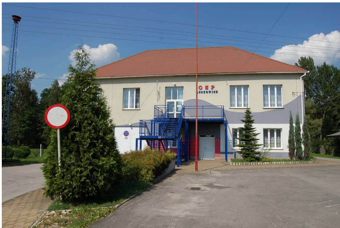
Budynek OSP w Luszowicach
