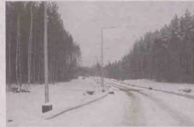
Budowa odcinka od ul. Topolowej do wiaduktu nad ul. Trzebińską
